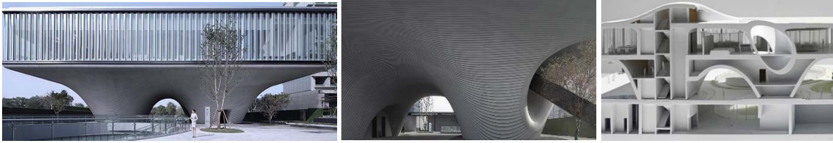
Resim 11. Genel Görünüm, GFRC Panellerden Oluşan Alt Kısım ve Bina Kesiti 8
