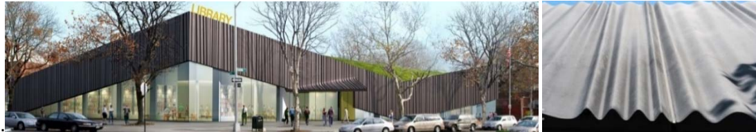
Resim 14. Kütüphanenin Yükselen Alçalan Formu ve Dalgalı GFRC Cephe 11
